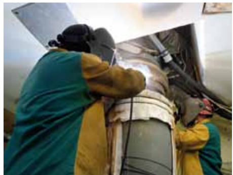
Bâtiments de sauvegarde. Soudures sur le circuit d'alimentation en eau des générateurs de vapeur. Photo EDF : les plus belles images de septembre 2017
