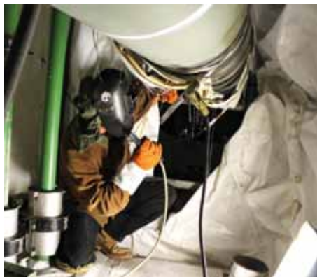
Bâtiment réacteur. 30 juillet : les réparations de soudures du circuit secondaire principal débutent. D'après photo EDF : les plus belles images de juillet 2018
