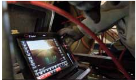
Bâtiment de sauvegarde : contrôle caméra des soudures des tuyauteries du circuit vapeur principal. Photo EDF : les plus belles images de février 2017
