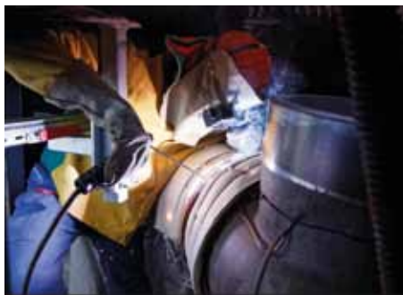
Bâtiment de sauvegarde. Les réparations sur le circuit secondaire se poursuivent. D'après photo EDF : les plus belles images de septembre 2018
