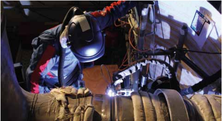
Bâtiment réacteur : Soudure orbitale sur le circuit vapeur principal. D'après photo EDF extraite de « EPR, les plus belles images d'octobre 2017 »
