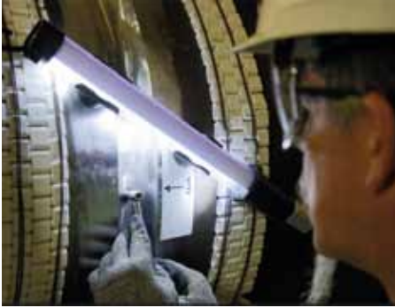
Bâtiment réacteur. Avant les réparations, des contrôles sont nécessaires sur les soudures du circuit vapeur principal (VVP). Ici la phase de ponçage avant la récupération de copeaux pour analyse.
