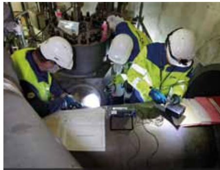
Bâtiment de sauvegarde : contrôle des soudures des tuyauteries du circuit secondaire principal. D'après photo EDF : les plus belles images d'avril 2018
